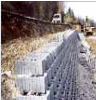
parements en blocs béton
